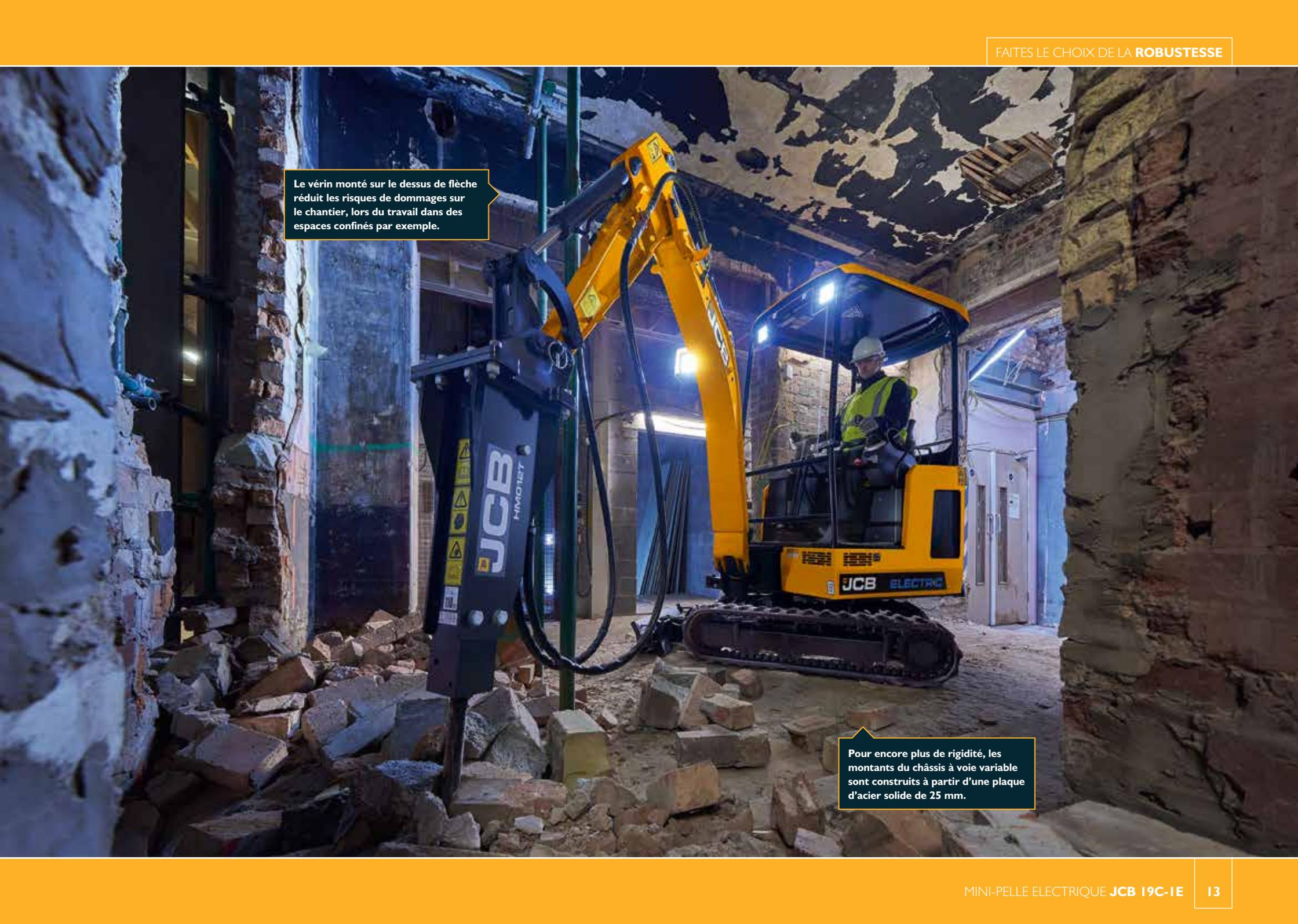
Le vérin monté sur le dessus de flèche réduit les risques de dommages sur le chantier, lors du travail dans des espaces confinés par exemple.
